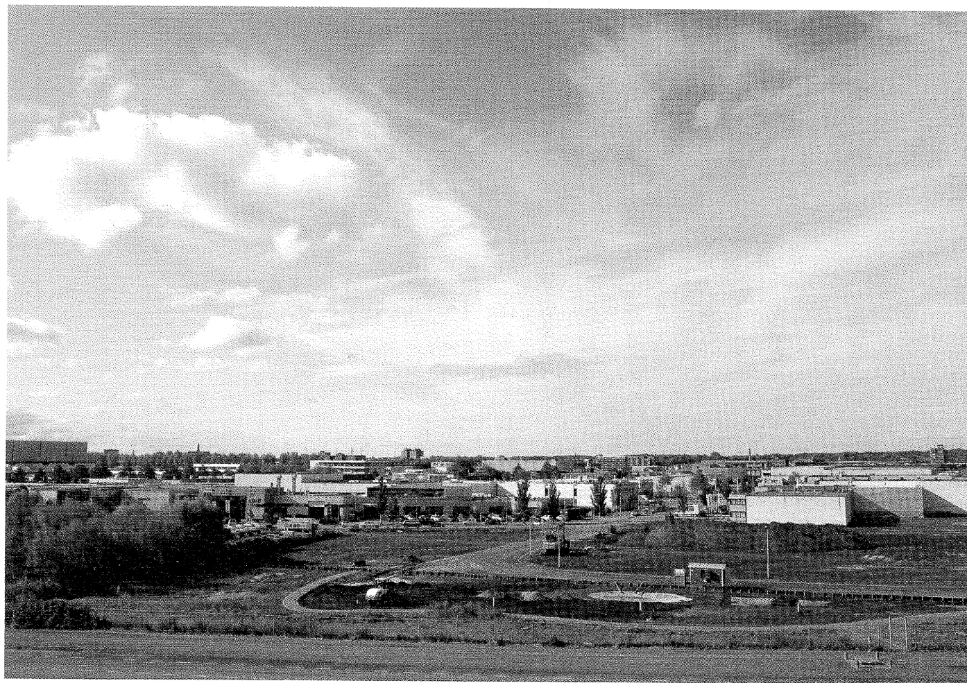
De noordpunt van het Haarlemse bedrijvenpark de Waarderpolder is bouwrijp gemaakt. Wegen en straatverlichting zijn er al, nu de bedrijven nog
