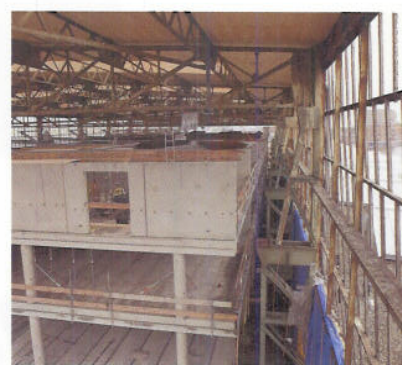
De bijzondere bouw binnen Figéehal 2: moderne, luxe bedrijfslofts binnen de oorspronkelijke constructie van de hal.
